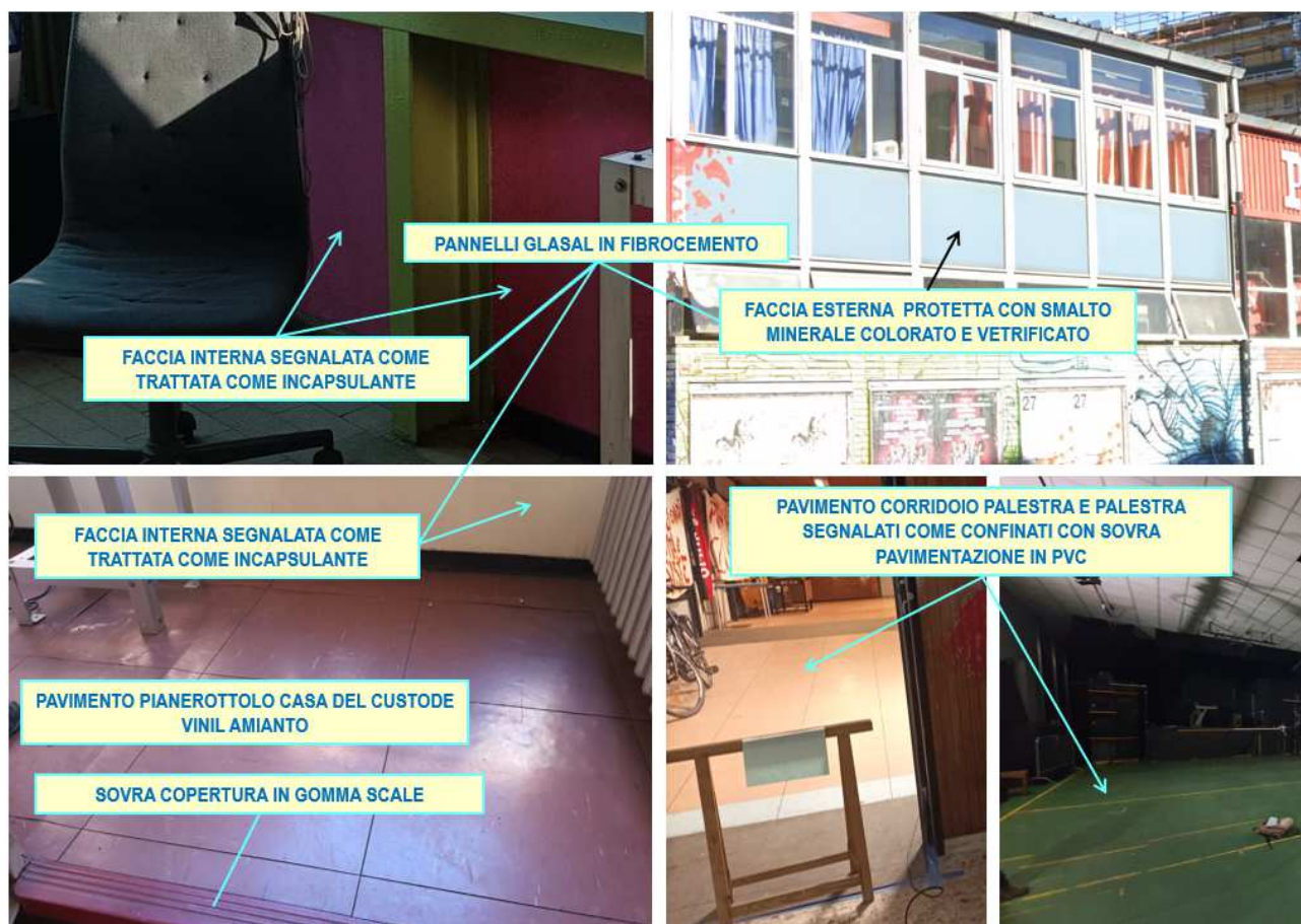
FIGURA 2-2: IMMAGINI DEGLI MCA PRESENTI NEGLI EDIFICI DELL' EX PLESSO SCOLASTICO ALIBERTI-PEZZANI E LORO CARATTERIZZAZIONE/UBICAZIONE
